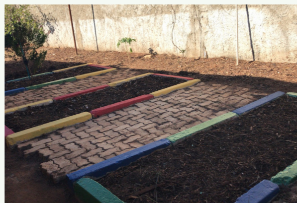
Figura 2 – Pintura dos canteiros
