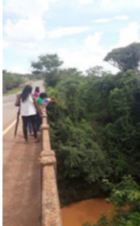
Imagem 27. Ponte sobre o rio Melchior.
