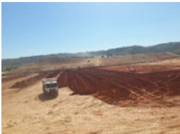
Imagem 14. Preparação para a compactação do solo
